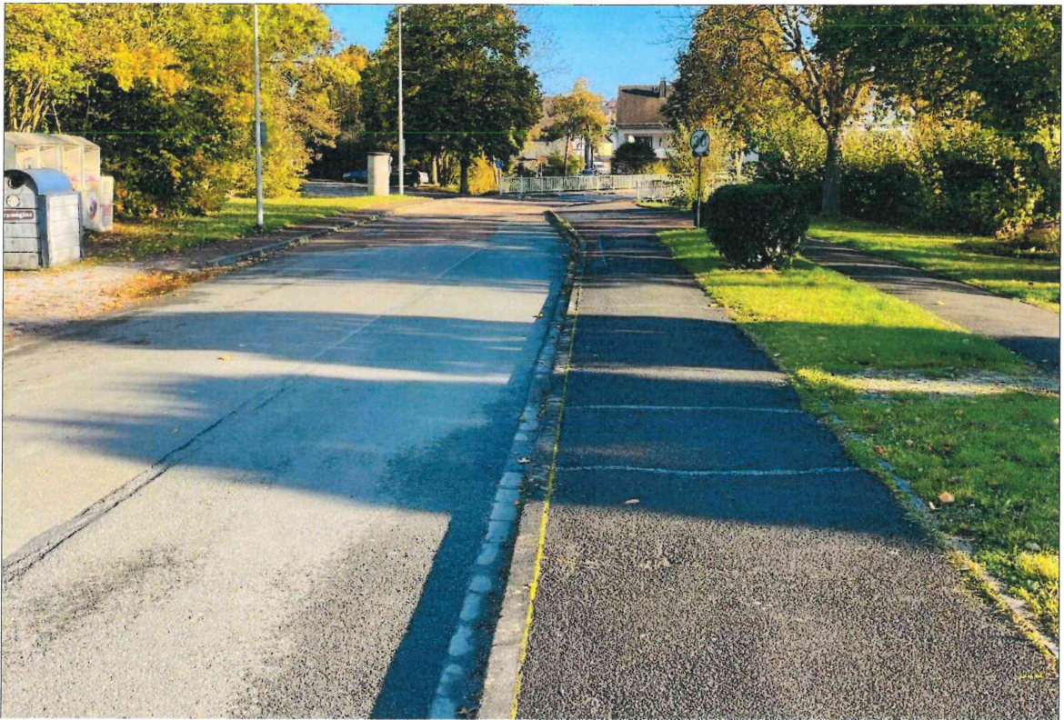
Foto, Blick von Süden entlang der Jahnstraße
