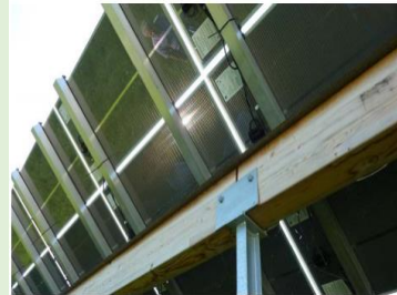
Lücken für Regenwasserabfluss
